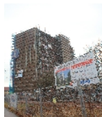
Fotonummer F 09301769 C Aufnahmejahr 2017 Fotograf Fischer, Mandy Beschreibung Bürohaus mit Verbindungsgang - Ansicht von N
