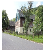
Fotonummer F 09299579 A Aufnahmejahr 2015 Fotograf Machold, Bärbel Beschreibung Wohnstallhaus und Scheune eines Zweiseithofes
