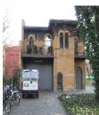
Fotonummer F 09295598 C Aufnahmejahr 2013 Fotograf Nitzsche, Mathis Beschreibung Nebengebäude (Remise mit Kutscherwohnung) einer Villa
