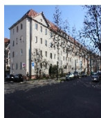
Fotonummer F 09294948 B Aufnahmejahr 2014 Fotograf Trajkovits, Thomas Beschreibung Mehrfamilienhäuser einer Wohnanlage (Erich-Zeigner-Allee 81, 83, 85, 87, 89, 91)
