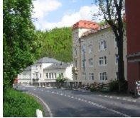
Fotonummer F 09278849 A Aufnahmejahr 2008 Fotograf Peker, Franziska Beschreibung Fabrikantenwohnhaus und Verwaltungs- und Produktionsgebäude der ehem. Schokoladenfabrik, heute Wohnhäuser
