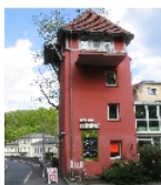
Fotonummer F 09278849 H Aufnahmejahr 2008 Fotograf Peker, Franziska Beschreibung Transformationshäuschen der ehem. Schokoladenfabrik, heute Bäckerei und Café
