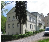
Fotonummer F 09278849 C Aufnahmejahr 2008 Fotograf Peker, Franziska Beschreibung Fabrikantenwohnhaus der ehem. Schokoladenfabrik
