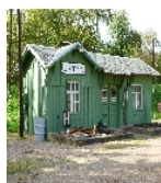
Fotonummer F 09268227 A Aufnahmejahr 2011 Fotograf Tepper, Tim Beschreibung Bahnhofsgebäude einer Kleinbahn
