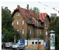
Fotonummer F 09264810 I Aufnahmejahr 2011 Fotograf Tepper, Tim Beschreibung Empfangsgebäude mit Einfriedung
