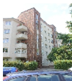
Fotonummer F 09264096 B Aufnahmejahr 2013 Fotograf Machold, Bärbel Beschreibung Mehrfamilienhäuser einer Wohnanlage; Front zur Karl-Heine-Straße von Nr. 1/1a/1b
