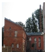
Fotonummer F 09261550 D Aufnahmejahr 2013 Fotograf Nitzsche, Mathis Beschreibung Fabrikgebäude im Hof
