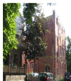
Fotonummer F 09261550 C Aufnahmejahr 2013 Fotograf Nitzsche, Mathis Beschreibung Fabrikgebäude im Hof
