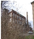
Fotonummer F 09241248 B Aufnahmejahr 2010 Fotograf Nitzsche, Mathis Beschreibung Fabrikgebäude
