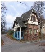
Fotonummer F 09241248 C Aufnahmejahr 2010 Fotograf Nitzsche, Mathis Beschreibung Pförtnerhaus einer Fabrik
