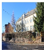
Fotonummer F 09237383 B Aufnahmejahr 2013 Fotograf Machold, Bärbel Beschreibung Wohnhaus, ehemaliges Schulgebäude
