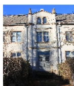
Fotonummer F 09237383 D Aufnahmejahr 2013 Fotograf Machold, Bärbel Beschreibung Wohnhaus, Eingangsachse der Straßenfront
