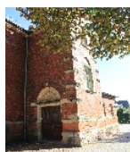
Fotonummer F 09229362 D Aufnahmejahr 2013 Fotograf Machold, Bärbel Beschreibung Postgebäude, Fassadendetail der südwestlichen Schmalseite
