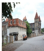
Fotonummer F 09221774 B Aufnahmejahr 2012 Fotograf Machold, Bärbel Beschreibung Papierfabrik, Blick auf Eingang und Hauptgebäude
