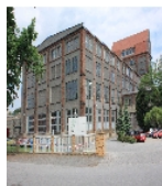
Fotonummer F 09221774 A Aufnahmejahr 2012 Fotograf Machold, Bärbel Beschreibung Papierfabrik, Ansicht Zufahrt und Nebengebäude
