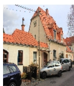
Fotonummer F 09216073 D Aufnahmejahr 2015 Fotograf Machold, Bärbel Beschreibung Doppelwohnhaus mit Waschhaus und Einfriedung, Teil einer Siedlung der Baugenossenschaft Dresden-Land e.G.m.b.H., Ansicht mit Nr. 19 im Vordergrund
