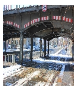
Fotonummer F 09214975 B Aufnahmejahr 2013 Fotograf Machold, Bärbel Beschreibung Eisenbahnbrücke, Ansicht konstruktive Details
