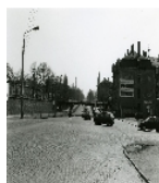
Fotonummer LXI/28/25A Aufnahmejahr 1996 Fotograf Wünderich, Andreas Beschreibung Blick auf die Eisenbahnbrücke (von Westen)
