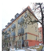
Fotonummer F 09213594 B Aufnahmejahr 2013 Fotograf Machold, Bärbel Beschreibung Häuserzeile, Ansicht Hofseite mit Hauseingang und angebauten Balkonen
