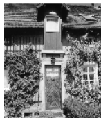
Fotonummer DF 414 173 Aufnahmejahr 1991 Fotograf Giersch, Steffen Beschreibung Reihenhäuser, Teilansicht der Fassade mit Eingangstür
