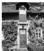
Fotonummer DF 414 173 Aufnahmejahr 1991 Fotograf Giersch, Steffen Beschreibung Reihenhauses, Teilansicht der Fassade mit Eingangstür
