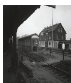
Fotonummer LII/82/5A Aufnahmejahr 1996 Fotograf Wagler Beschreibung Empfangsgebäude, Unterführungsüberdachung, Gleisanlage und Bahnsteigüberdachung
