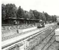
Fotonummer CIII/43/15 Aufnahmejahr 2003 Fotograf Finkler, Lutz Beschreibung Bahnsteigüberdachung
