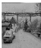
Fotonummer DF 410 685 Aufnahmejahr 1991 Fotograf Petrik, Ivo Beschreibung Eisenbahnbrücke über das Sehmatal, Ansicht von der Dorfstraße
