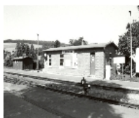
Fotonummer CIII/42/4 Aufnahmejahr 2003 Fotograf Finkler, Lutz Beschreibung Empfangsgebäude (Nr. 6c) und Toilettenhäuschen
