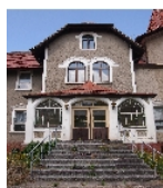
Fotonummer F 08974181 B Aufnahmejahr 2016 Fotograf Peker, Franziska Beschreibung Herrenhaus, Ansicht des Haupteingangs von Südosten
