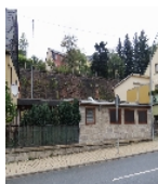
Fotonummer F 08957661 A Aufnahmejahr 2013 Fotograf Hoppe, Hans Dirk Beschreibung Stützmauer an der Bahnlinie
