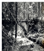
Fotonummer LXXIII/79/16 Aufnahmejahr Fotograf Beschreibung Betonbogenbrücke
