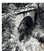
Fotonummer LXXIII/79/18 Aufnahmejahr Fotograf Beschreibung Betonbogenbrücke
